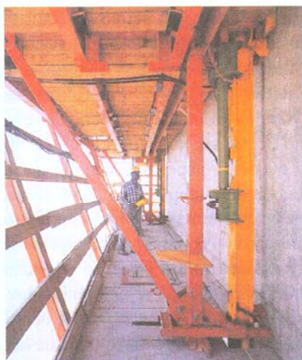
Рис. 2.25. Подъемно-переставная опалубка фирмы «Perі ACS»: а - общий вид; б - опорно-подъемное устройство
