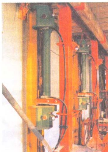
Рис. 2.25. Подъемно-переставная опалубка фирмы «Perі ACS»: а - общий вид; б - опорно-подъемное устройство
