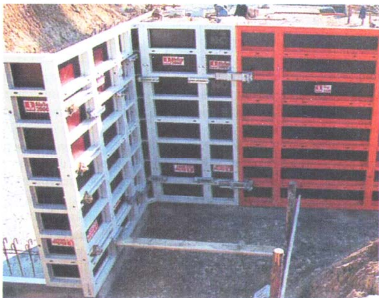
Рис. 2.7. Опалубка «НОЕ Alu Top 2000»: а - стальная рамная опалубка с алюминиевыми элементами жесткости; б - угловые элементы алюминиевой опалубки
